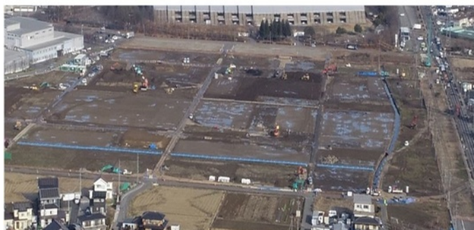
造成中のエムウェーブ南産業団地
