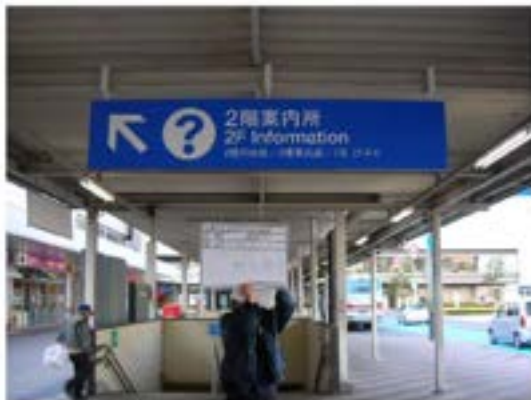
天井への設置
