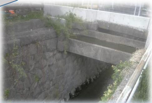
湯福川と鐘鑄堰の立体交差
