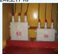
高圧コンデンサー (平成2年以前製造)
