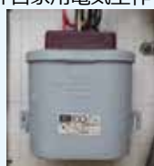
低圧コンデンサー (平成2年以前製造)
