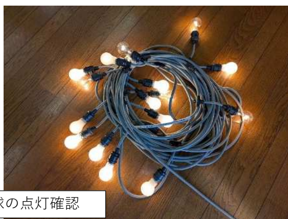
電球の点灯確認（自治会館南側電源盤に接続）
