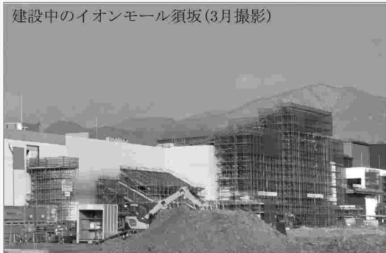
建設中のイオンモール須坂(3月撮影)
