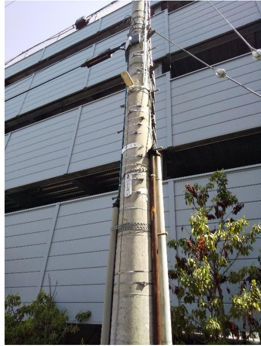
<例：灯具の設置が確認できる写真>
