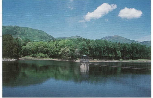
創設以来の水源、戸隠水源貯水池
