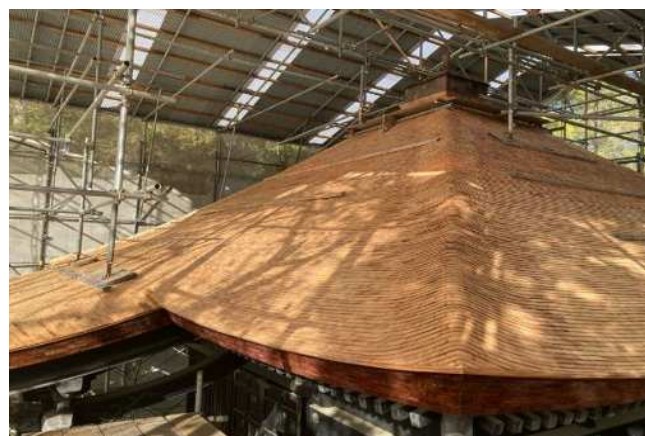
葺き替え後の屋根 (宝殿)
