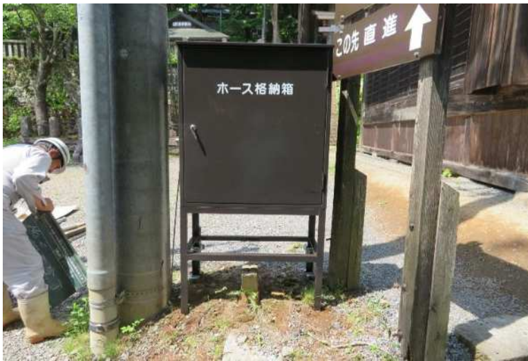
←小口径ホース格納小屋設置工事
