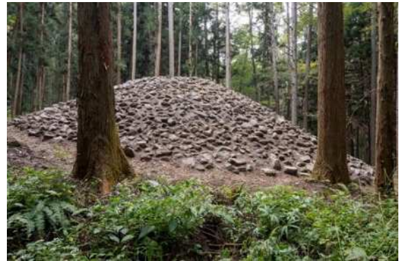
保存整備工事实施状況 (172号墳 背面から)
