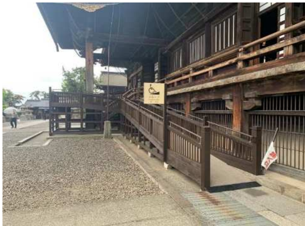
善光寺本堂スロープ設置
