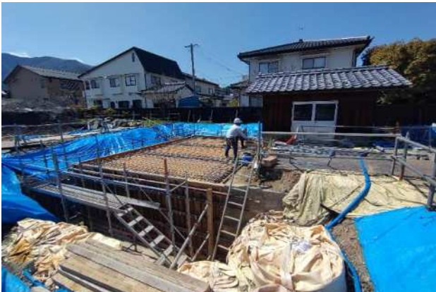
防火水槽の増設
