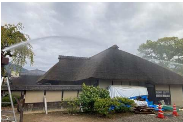
自動首振り式放水銃の動作試験
