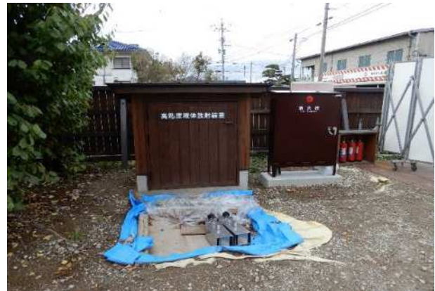
高粘度液体放射装置の新設
