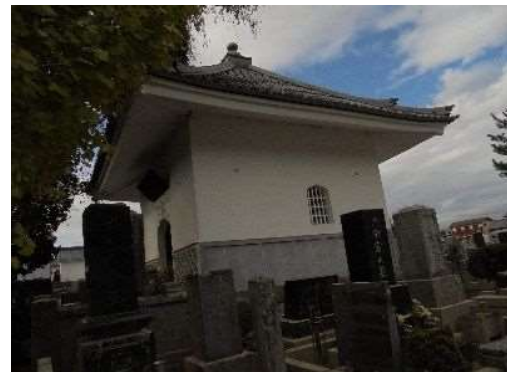
経蔵(修理前外観)
