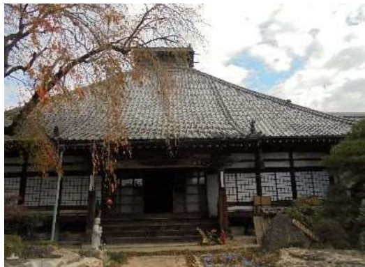
長明寺本堂(修理前外観)
