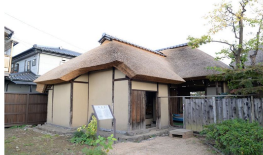
隠居屋 (修理後)
