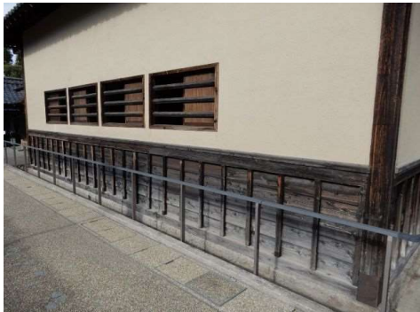
旧文武学校の保存修理状況
