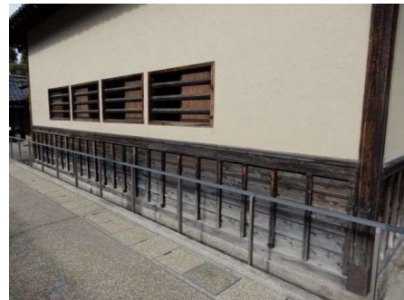
剣術所柵設置状況
