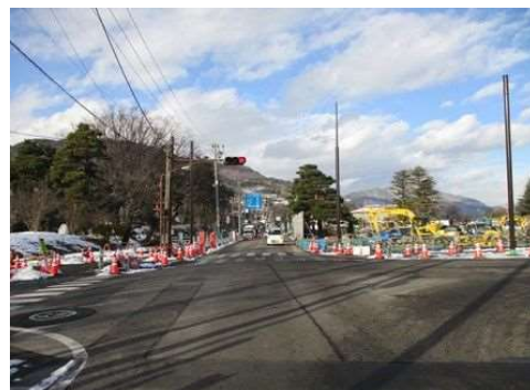
歩道橋撤去後 (R2.12)
