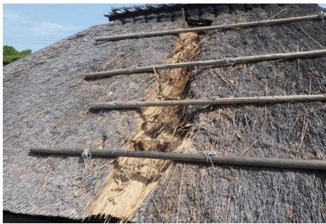
旧横田家隠居屋 (旧茅材解体状況)
