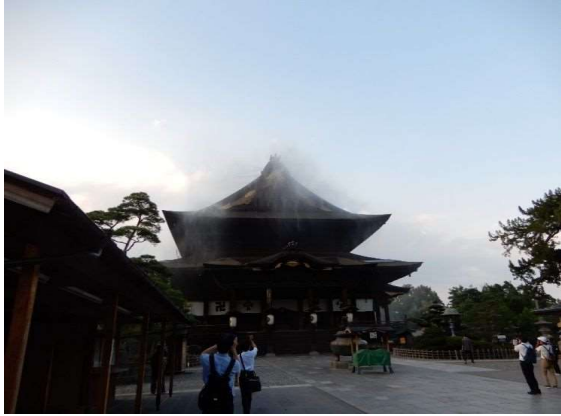
善光寺本堂ドレンチャー設備の放水試験
