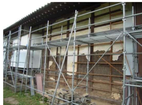
長明寺(松代地区)の保存修理状況
