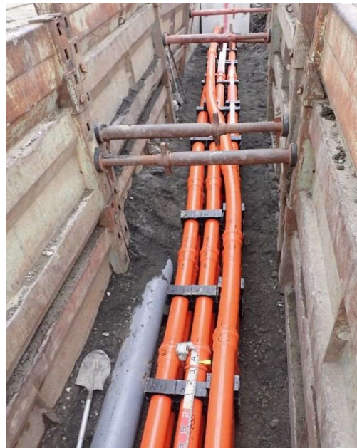
管路布設状況
