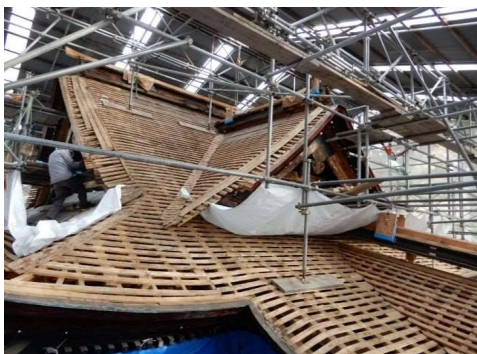
屋根修理状況(宝殿/北西隅)
