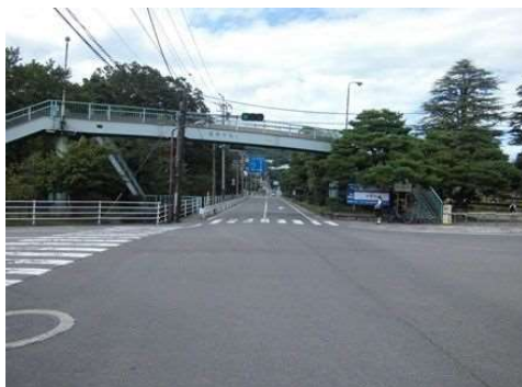
歩道橋撤去前 (R2.3)
