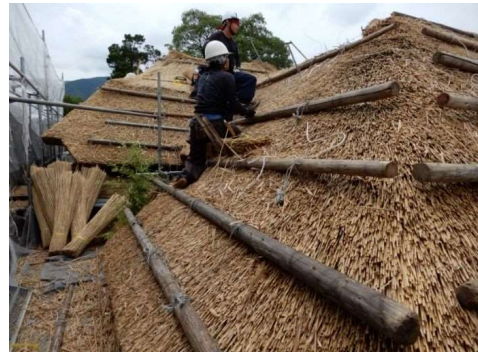
旧横田家住宅の保存修理状況
