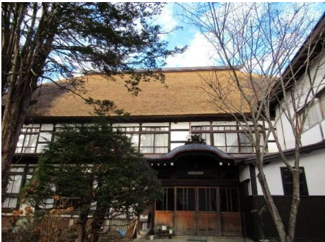
重伝建(戸隠地区)の保存修理状況
