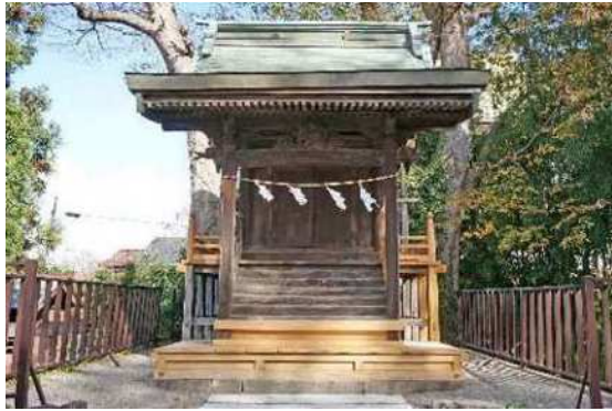
本殿 外観（南面）南よりみる
