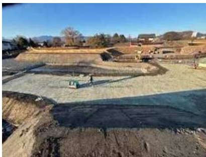
二の丸遺構外整備状況(R7.12)
