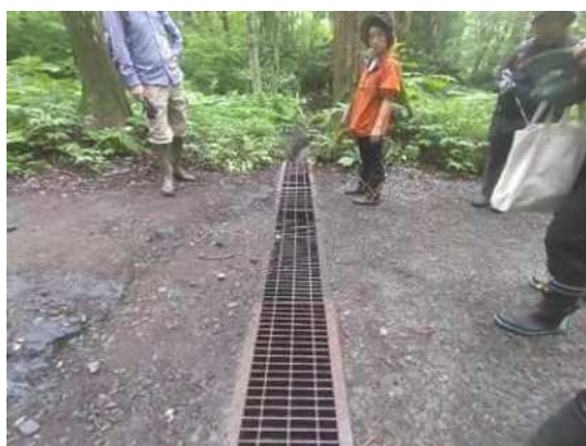
既存横断側溝①
