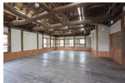
2 階多目的室（竣工写真）
