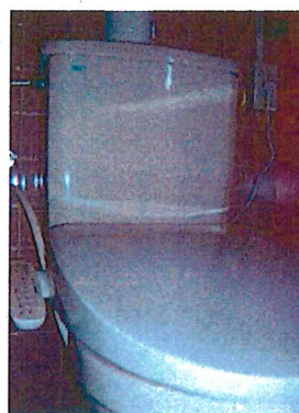
● 一階女子トイレ（施工後）
