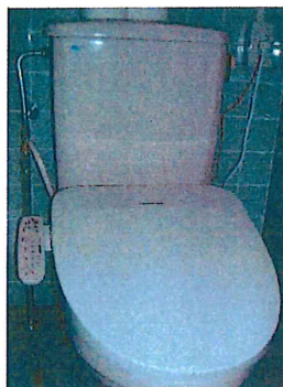
● 二階男子トイレ (施工後)
