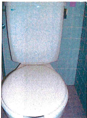
○ 一階男子トイレ（施工前）
