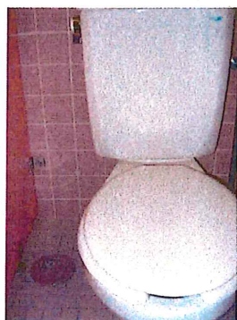
○ 一階女子トイレ（施工前）
