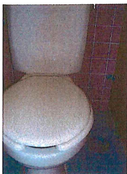
○ 二階女子トイレ (施工前)
