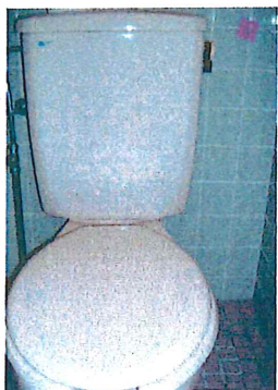
○ 二階男子トイレ (施工前)
