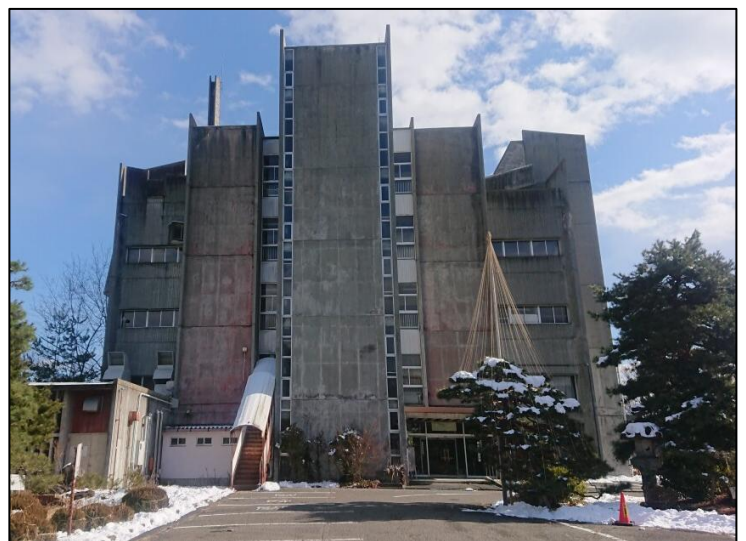
解体する城山公民館別館（旧蔵春閣）
