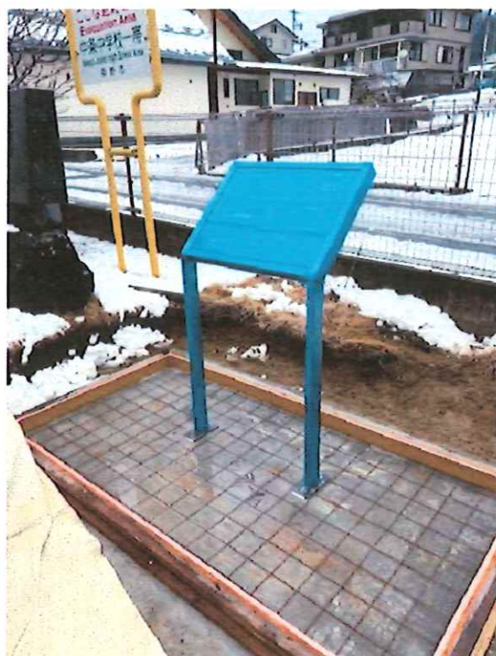
フレーム取付
