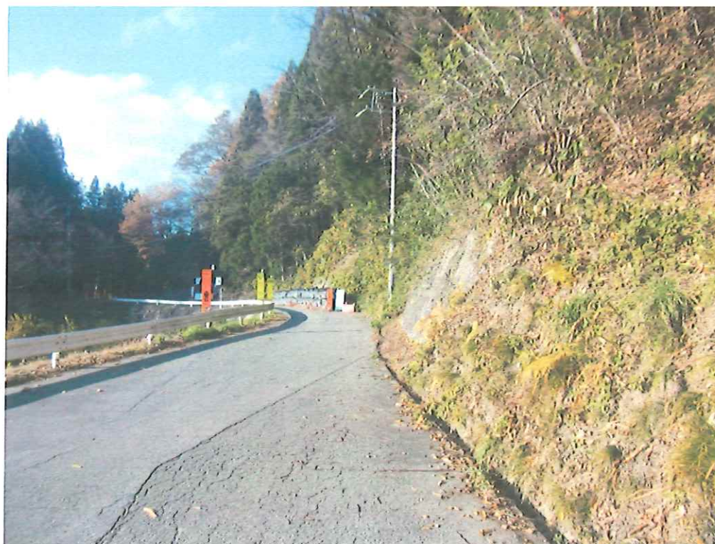
竣工 埋橋口先
