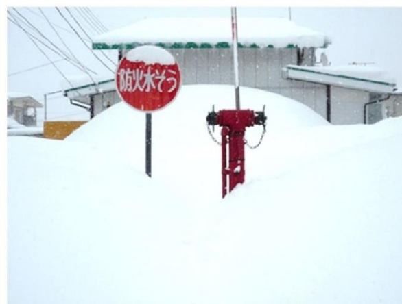
(参考) 積雪時でも吸水を容易にするサクシオンパイプの事例
