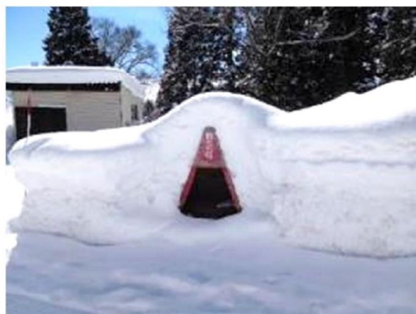
中社地区での防火水槽の積雪対策
