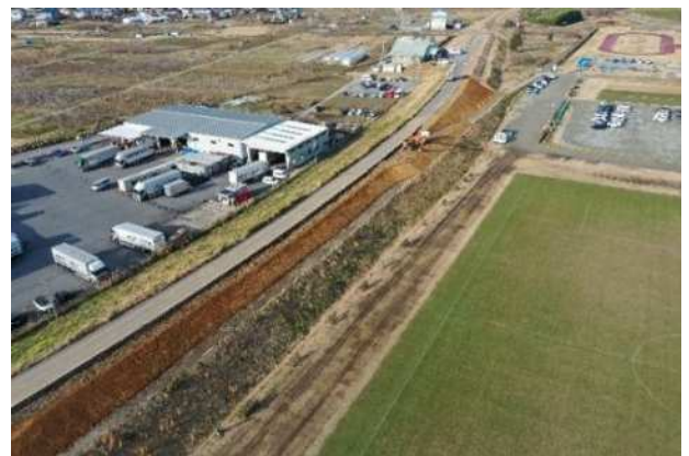
若里村山堤防線 整備状況
