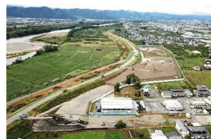
（仮称）長沼総合市民センター建設予定地
