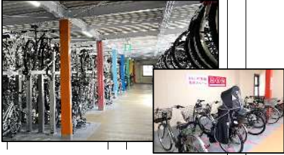
【駐輪場の長寿命化改修工事】 (長野駅自転車駐車場)
