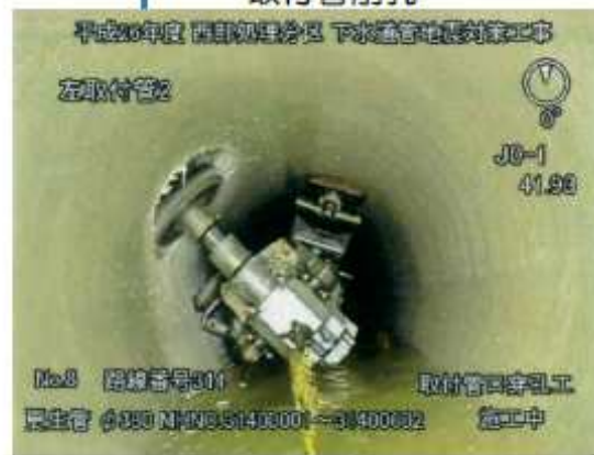
取付管削孔
