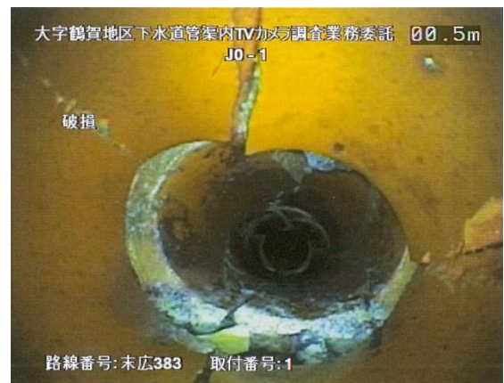
陶管製取付管の破損・扁平事例
