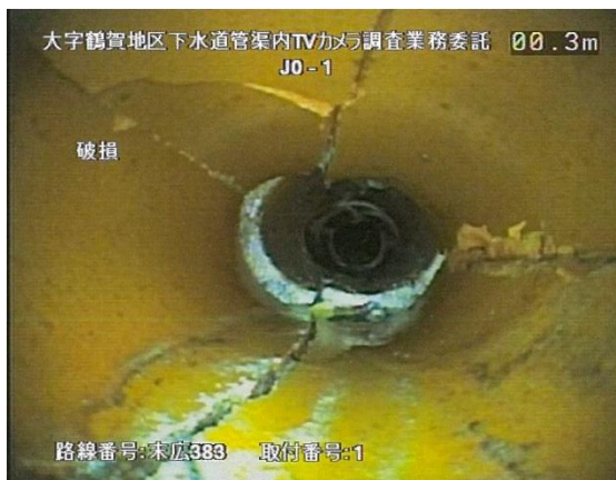
陶管製取付管の破損・扁平事例
