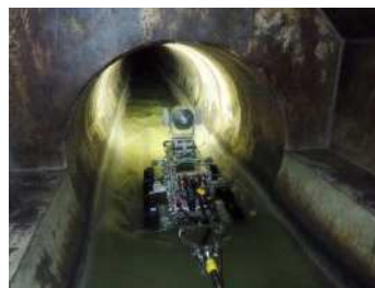
管径60cm以上の管路の TVカメラ調査
