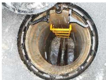
マンホール内部、鉄蓋の 点検
