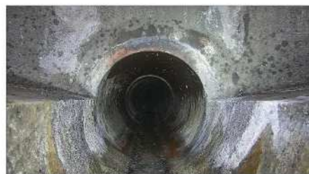
マンホール内部から目視または 管口カメラによる管路内点検
