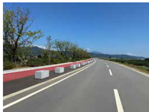
河川防災ステーション付近の堤防道路(県道)の状況
