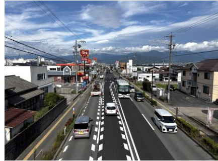
国道18号 北尾張部交差点付近
