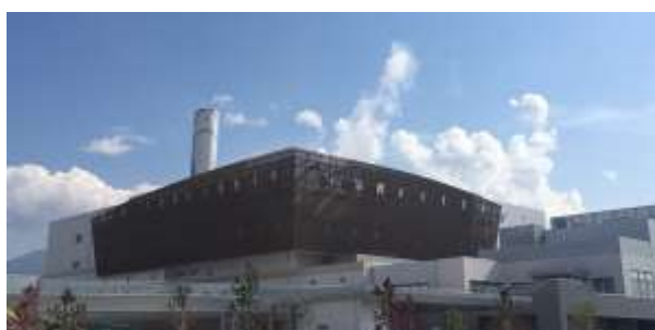
ながの環境エネルギーセンター
