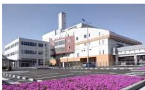
ちくま環境エネルギーセンター
