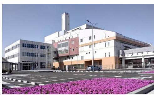
ちくま環境エネルギーセンター
