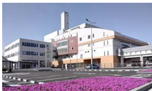
ちくま環境エネルギーセンター
