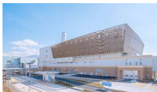
ながの環境エネルギーセンター
