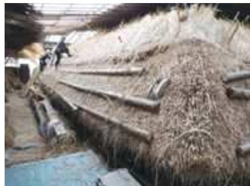
茅葺屋根の修理の様子
