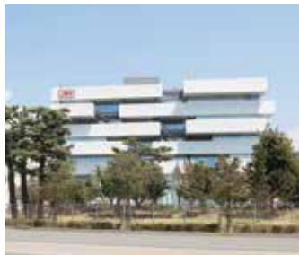
127 日本無線 先端技術センター
