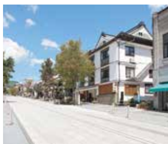
129 善光寺表参道の歩道拡幅と 石畳化（公共）
