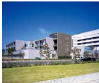
97 長野市民病院 中央棟、南病棟（公共）
