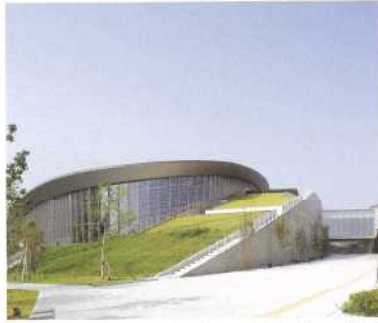
135 サンマリーンながの、リサイクルプラザ
