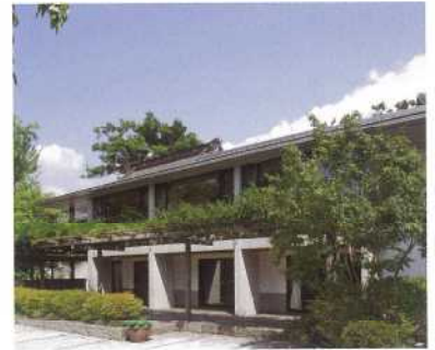
138 地域に開かれた緑のオアシス・西光寺門徒会館
