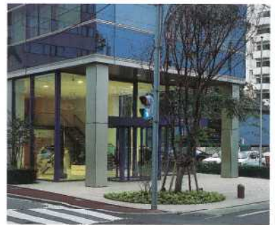
26 北野建設株式会社本社ギャラリー棟及び前庭 (令和3年建替え)
