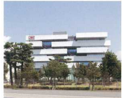
127 日本無線 先端技術センター
