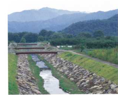
45 神明広田都市下水道堤外水路(公共)
