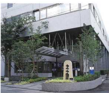
24 長野県労働金庫
