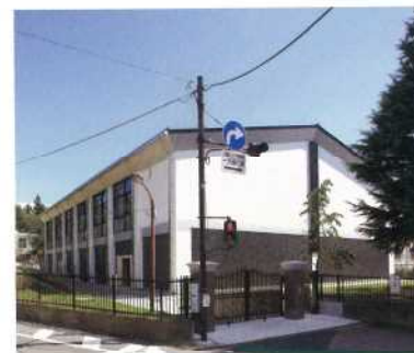
110 城山小学校体育館(公共)
