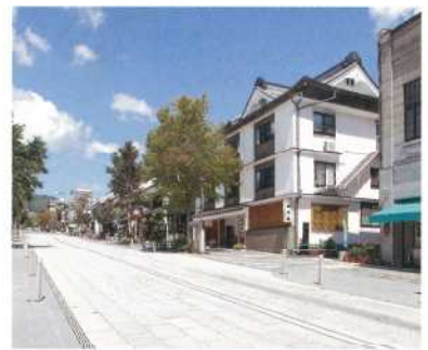
129 善光寺表参道の歩道拡幅と石畳化(公共)
