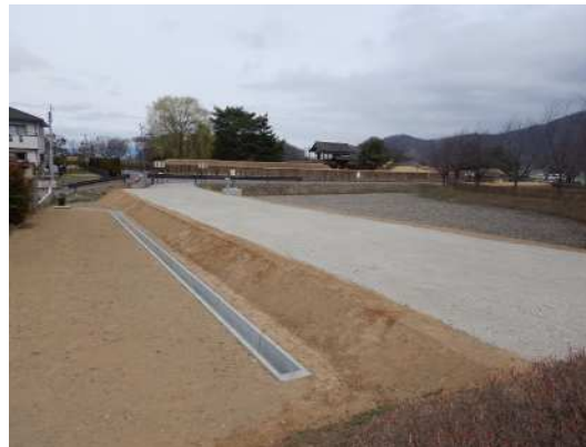
外周園路整備工事状況(令和4年度)
