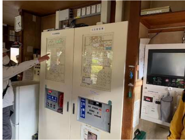
自動火災報知設備の更新・新設(令和4年度)
