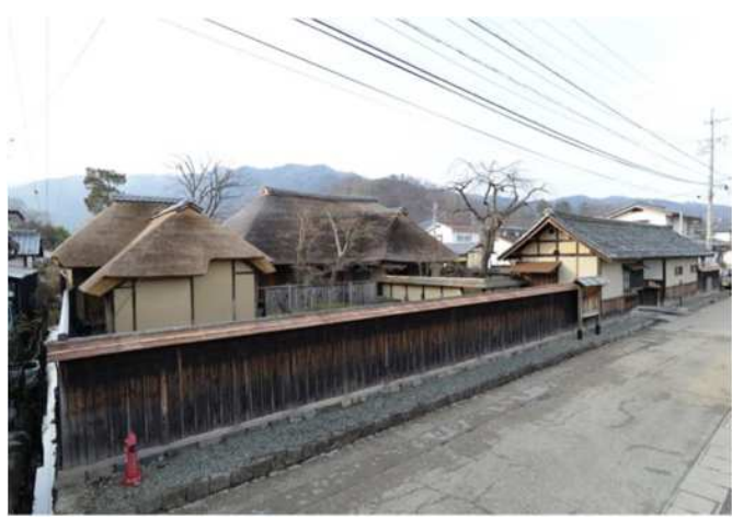
旧横田家住宅 全景(北東から)
