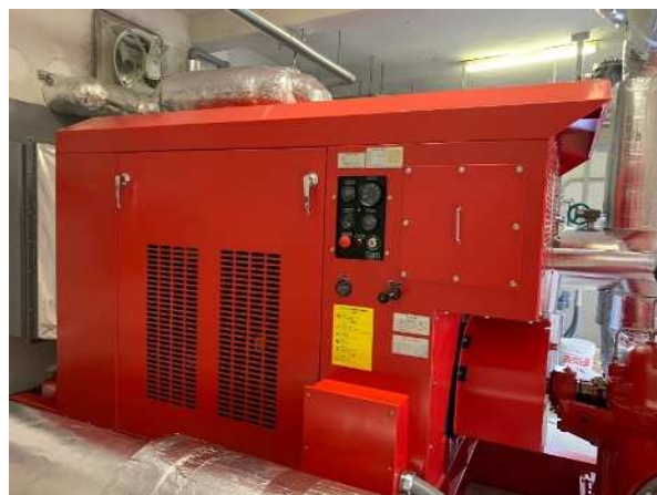
消火設備の更新・放水試験(令和4年度)
