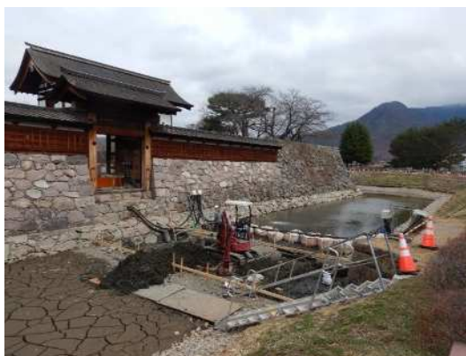
太鼓門前橋外整備工事状況(令和4年度)
