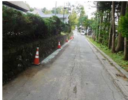
道路美装化に伴う構造物施工状況
