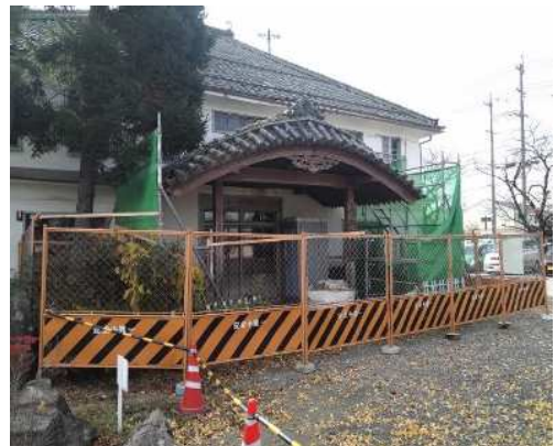
旧作新学校本館の保存修理状況
