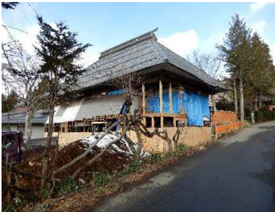
重伝建(戸隠地区)の保存修理状況
