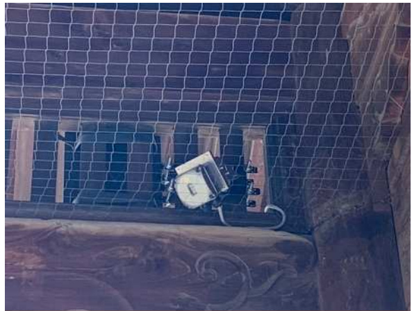
三門 炎検知器の新設
