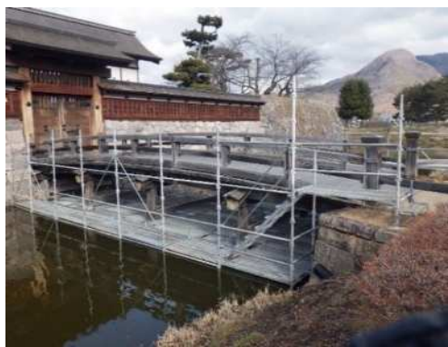
太鼓門前橋・二の丸引橋等の整備工事
