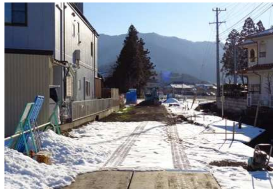
着工状況(令和4年12月現在)
