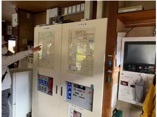
自動火災報知設備の新設(R型受信機の増設等)
