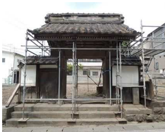
写真2 門外観(東から)撮影
