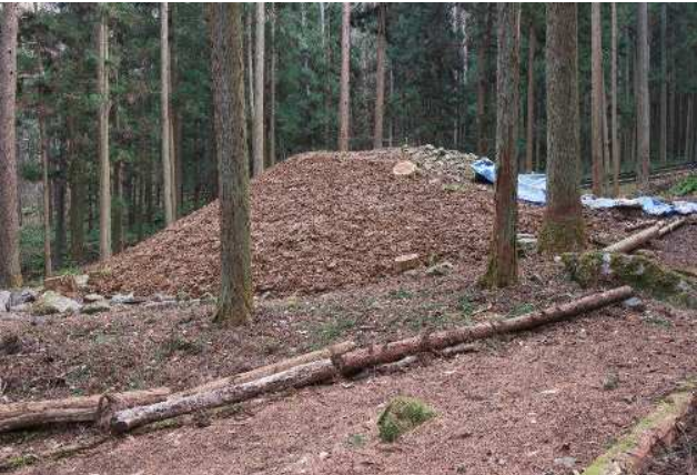
172号墳 令和5年度整備工事完了状況 斜面下方側
