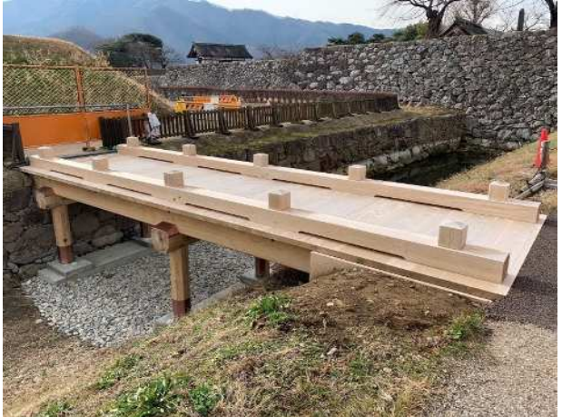
太鼓門前橋外整備工事(二の丸引橋)
