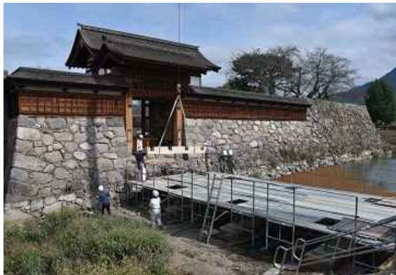
松代城跡 太鼓門前橋整備工事
