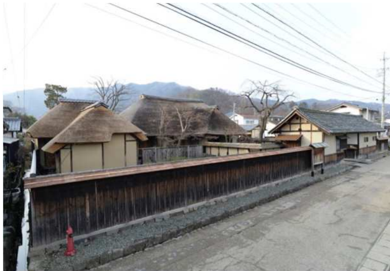
旧横田家住宅 全景 (北東から)
