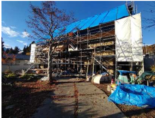
全景(R5年度修理工事中)
