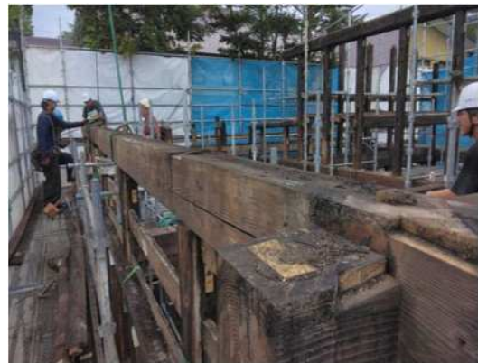
部材解体作業(R5年度修理工事中)
