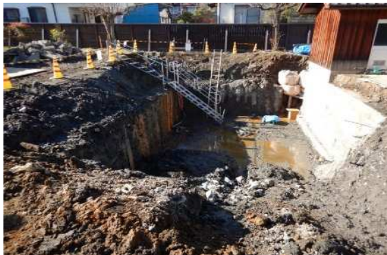
旧横田家住宅 防火水槽設置箇所掘削状況
