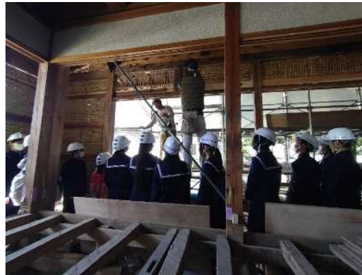
中学生による修理工事見学会
