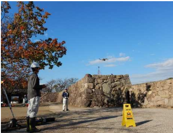
石垣測量調査(本丸東石垣)
