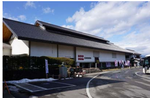
現在の真田宝物館 (S36年建設) 施設の老朽化、展示施設機能の不備、収蔵庫不足等の課題を抱えている。
