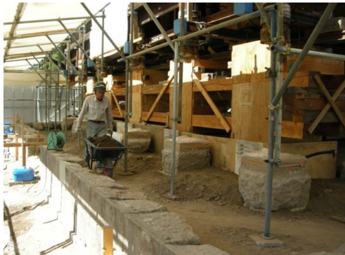
善光寺経蔵 基壇修理工事
