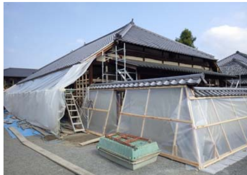
槍術所 工事外観
