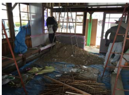
改修工事の様子
