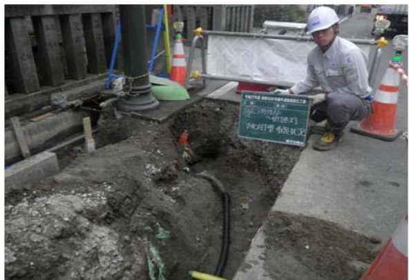
街路灯電源接続の様子
