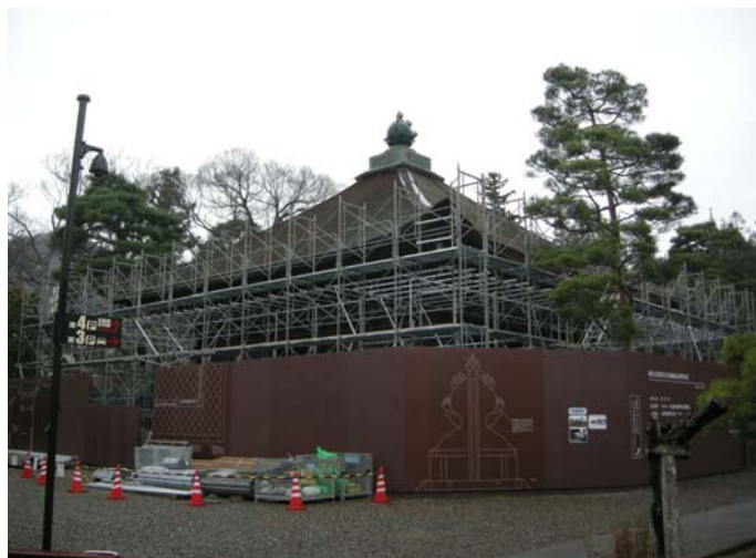
善光寺経蔵 仮設工事
