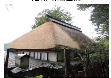
越志旅館 H27年度施工箇所 (客殿 東面屋根)
