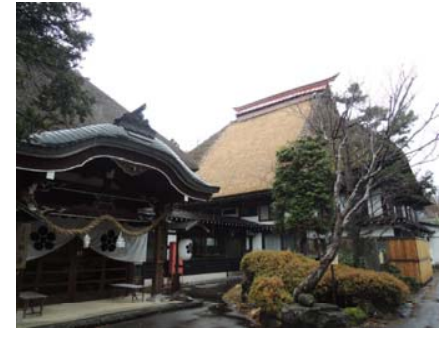
宿坊極意 H26年度施工箇所 (庫裡 西面屋根)
