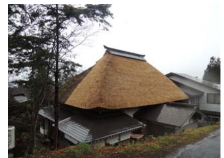
武井旅館 H26年度施工箇所 (主屋 北面屋根)
