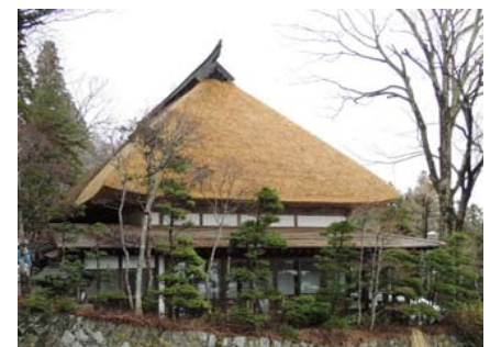
越志旅館 H26年度施工箇所 (客殿 西面屋根)
