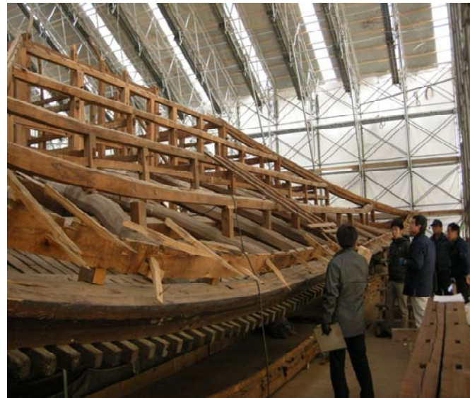
善光寺経蔵 屋根解体状況
