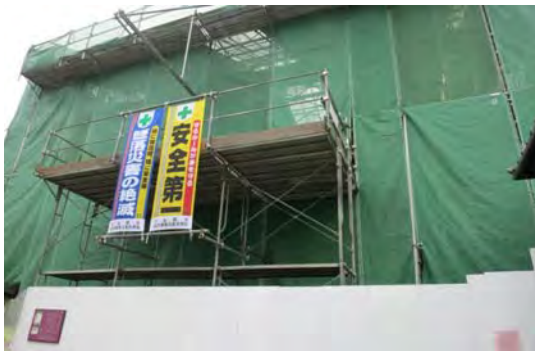
覆屋設置状況
