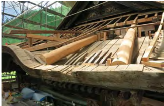
屋根修理状況
