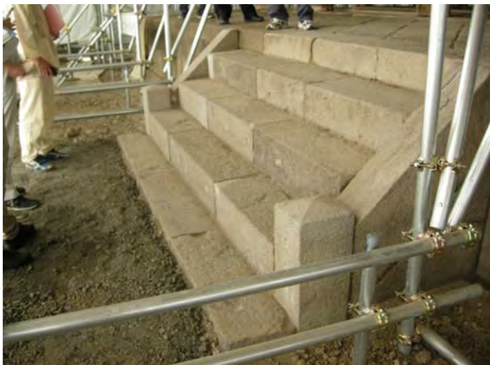
善光寺経蔵 基礎工事
