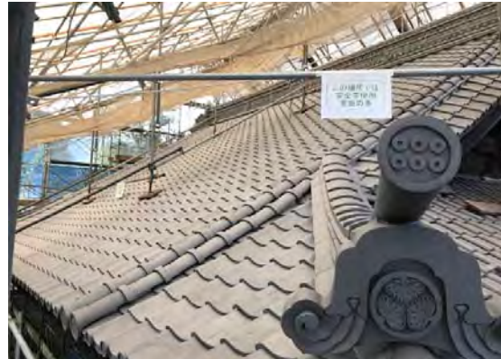
大英寺本堂屋根瓦吹き替え
