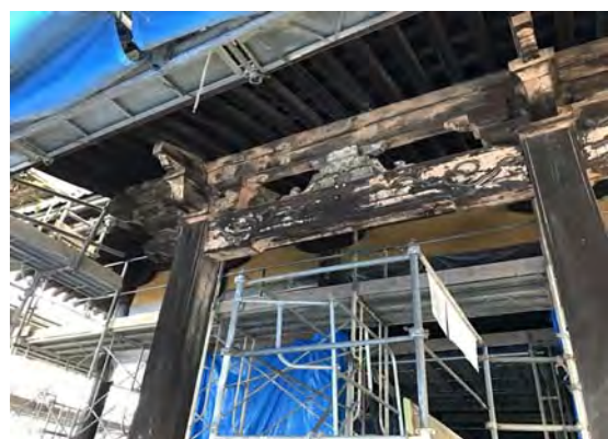
外壁他修理状況
