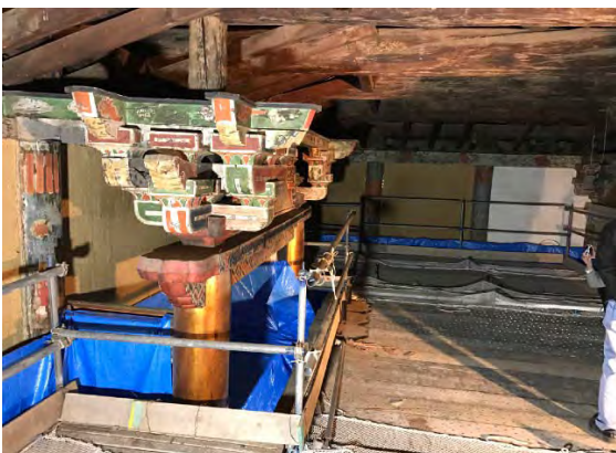
内陣解体状況
