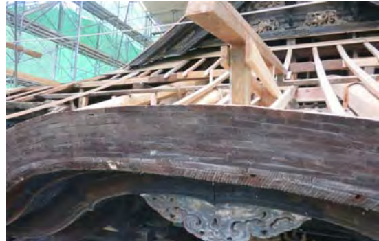
屋根修理状況
