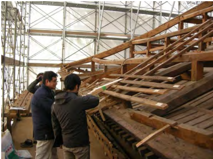
善光寺経蔵 屋根工事 (文化庁指導)
