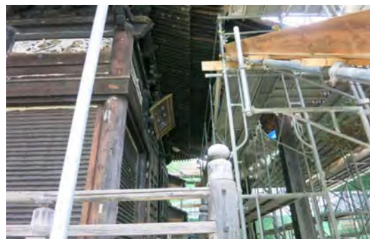
屋根修理状況
