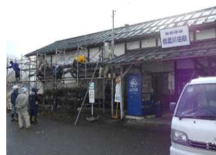
住民による駅舎壁面塗装の様子
