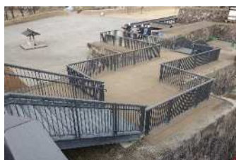
櫓台階段・柵の整備(R2.1)
