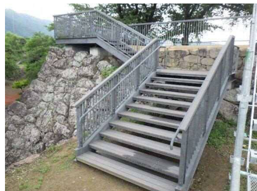
櫓台階段(上段)の再整備
