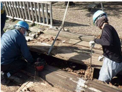
腐朽した櫓台階段(既存)の解体
