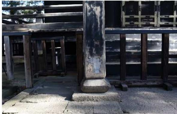
向拝柱漆塗破損状況(宝殿)
