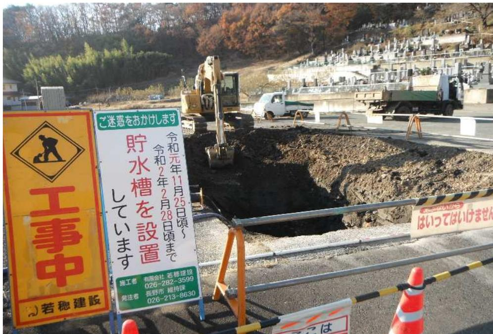
耐震性貯水槽設置工事の状況(R1. 12. 9)
