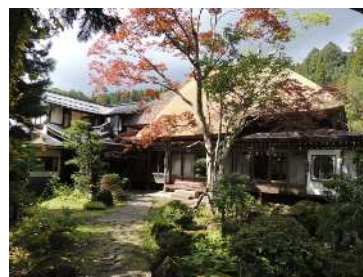
建造物修理事業 H27.11
