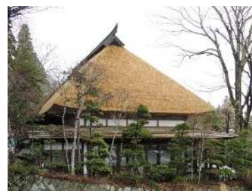
建造物修理事業 H26.11
