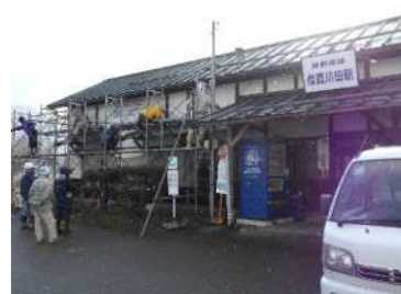
住民による駅舎壁面塗装の様子
