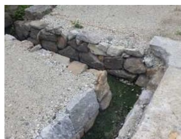
石組水路の改修 （H30伝統環境保存事業）
