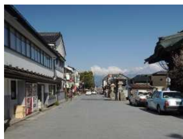
無電柱化・道路美装化 H28.5
