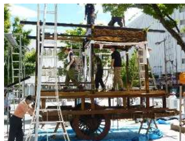
屋台組み立て状況（問御所町）
