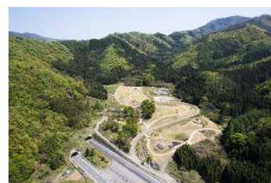
エントランスゾーンの H26.5 整備状況
