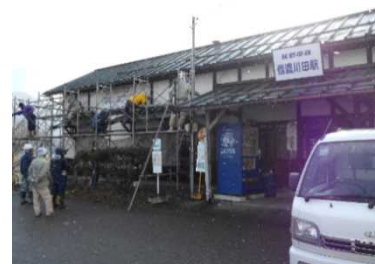
住民による駅舎壁面塗装の様子
