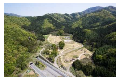
エントランスゾーンの整備状況 H26.5
