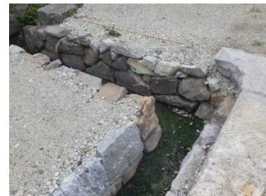
石組水路の改修 (H30伝統環境保存事業)
