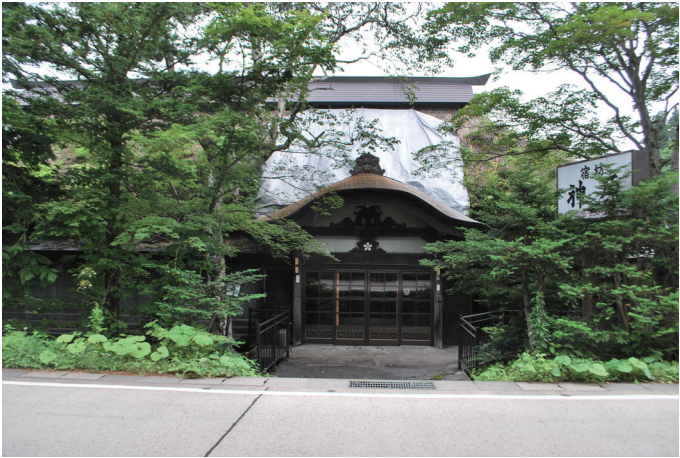
写真1 宿坊外観（東から）
