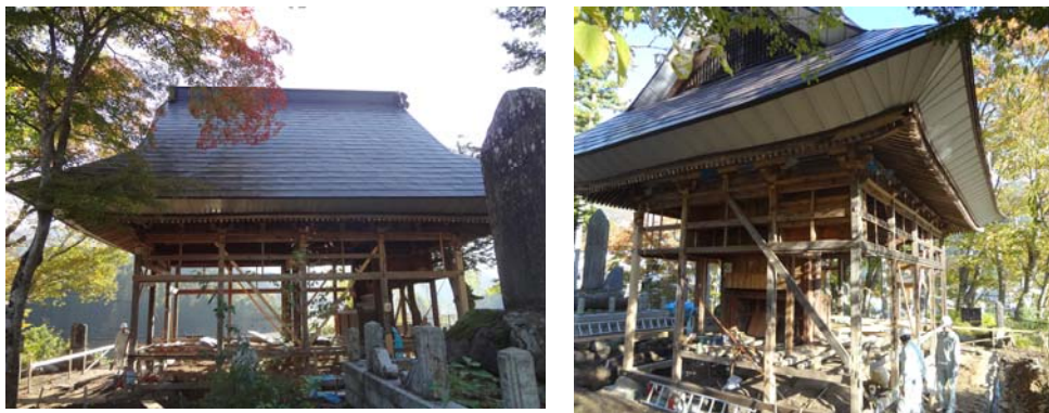
工事状況写真(平成25年11月状況)
