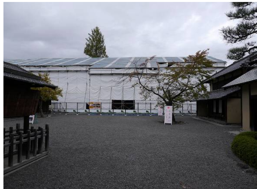
文学所 工事外観
