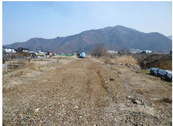
<レール等の撤去後>
