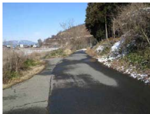
大室古墳群アクセス道路 現況
