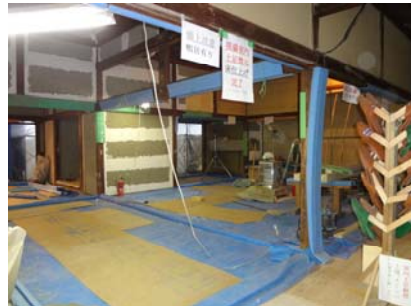
寺町商家主屋内部
