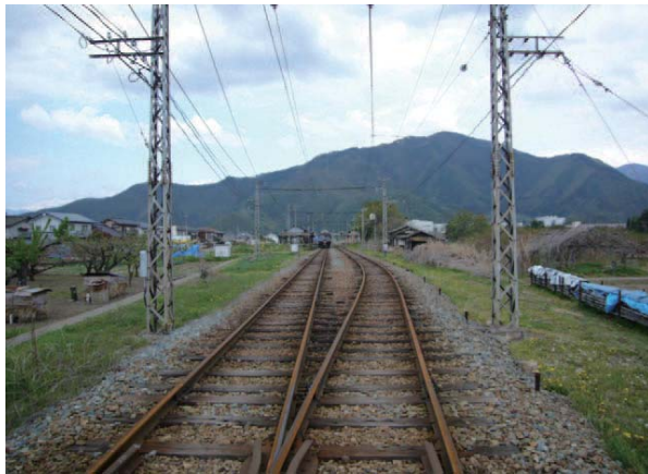
<レール等の撤去前>
