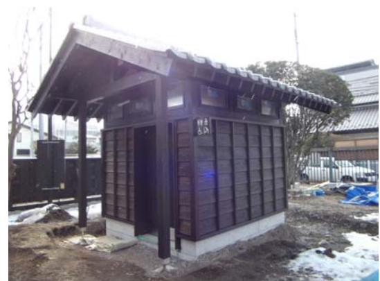
トイレ棟設置
