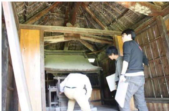
歴史的建造物調査状況
