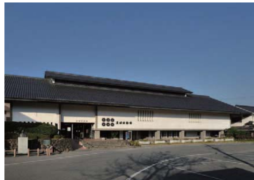
現在の真田宝物館 (S36年建設) 施設の老朽化、展示施設機能の不備、収蔵庫不足等の課題を抱えている。
