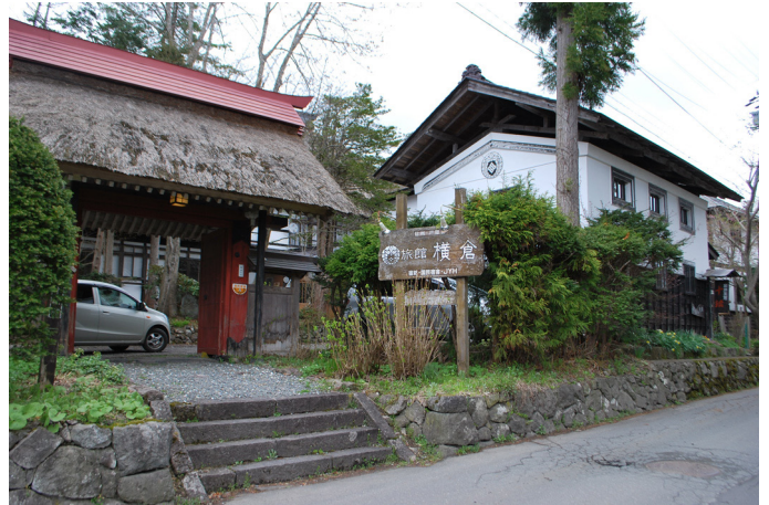
写真2 門外観（南西から）
