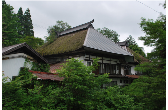
写真2 宿坊外観（北西から）
