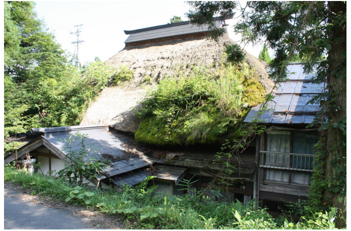
写真2 宿坊外観（北西から）
