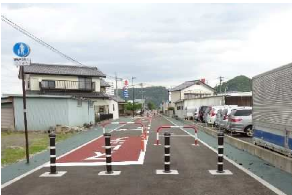
整備済みの自転車道・遊歩道
