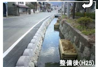
松代地区 小鮎川 改修
