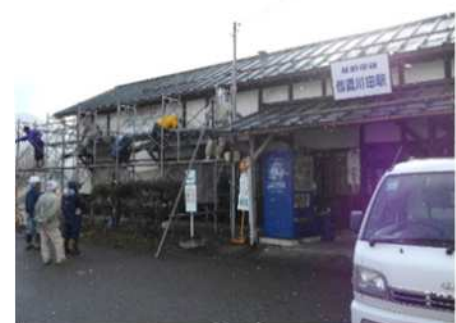
住民による駅舎壁面塗装の様子
