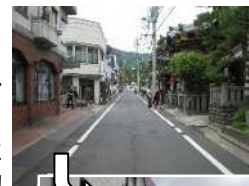
善光寺周辺 道路美装化 電柱類地中化
