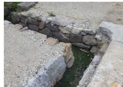
石組水路の改修 (H30伝統環境保存事業)
