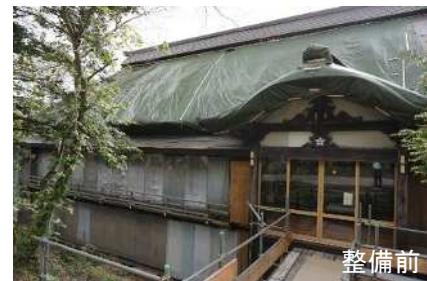
宿坊の茅葺屋根修理
