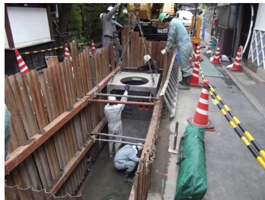
新迦堂通りの電線類地中化工事
