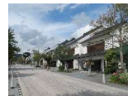
善光寺門前のまちなみ (長野市大門町)
