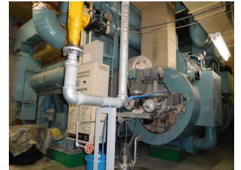
撤去困難な機械設備
